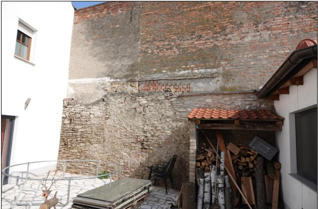
Nördlicher Abschnitt mit Mauerwerk der Erstbauphase (Ziegelaufbau rezent)
