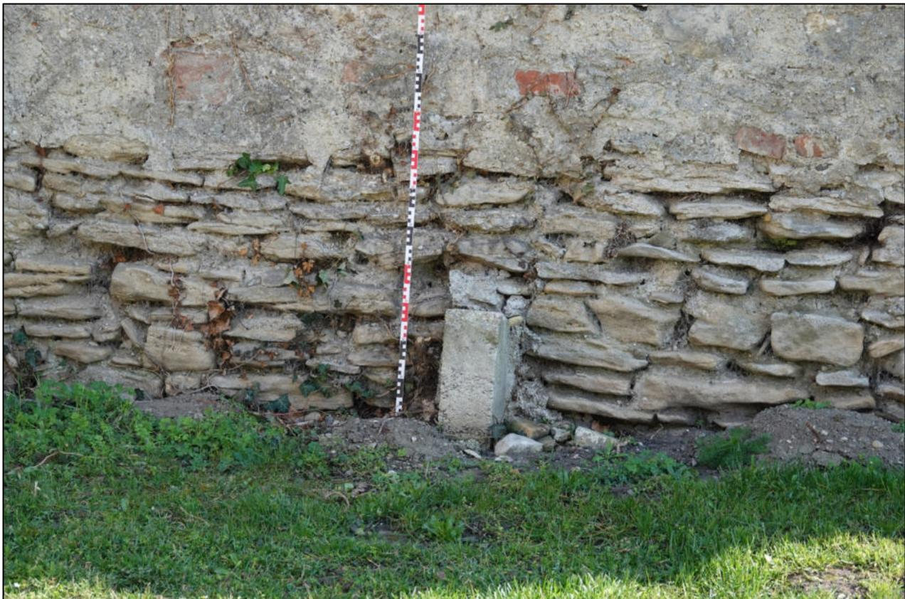
**Abb. 34:** Typisches Mauerwerk der Erstbauphase (hier: Gst. 123 Feldseite) mit plattigen Formaten, die Reihen von quaderförmigen Steinen einbinden
